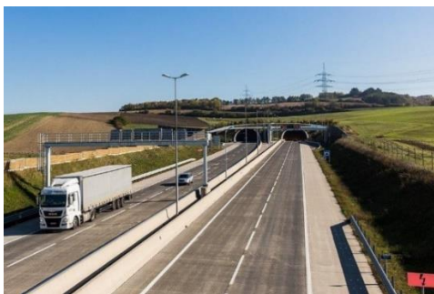
Reinigungs- und Wartungsarbeiten im Tunnel Tradenberg an der A5/S1
