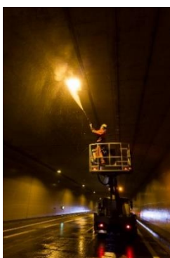
Tunnelreinigung bei Bonaventura.
